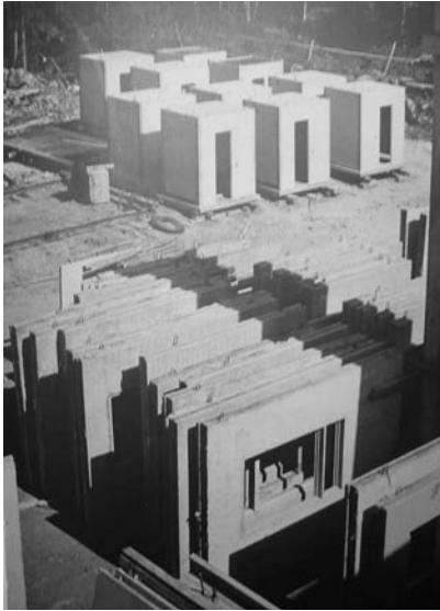
Uutta nopeaa rakennustekniikkaa. Ny och snabb byggtknik. (SEA)
