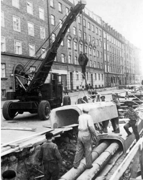
Kaukolämpötiitä Runeberginkadulla. (SEA) Fjärrvärmarbeten på Runebergsgatan.
