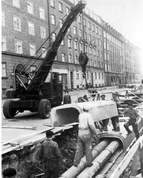
Kaukolämpötöitä Runeberginkadulla. (SEA) Fjärrvärmearbeten på Runebergsgatan.
